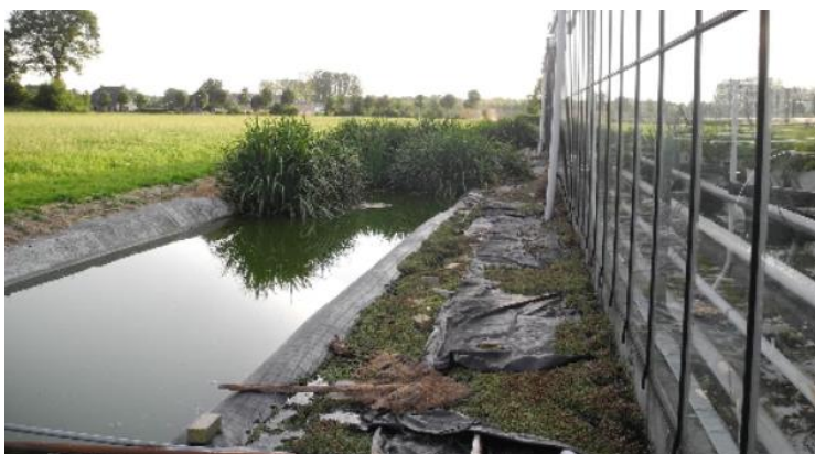
Figuur 3. Moerasfilter aangelegd bij een aardbeienteler.
